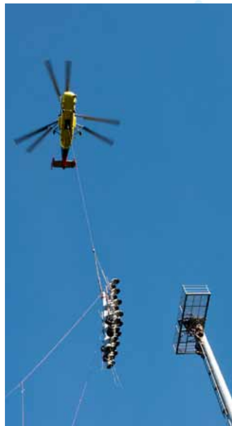
Монтаж «короны» с помощью вертолета Ка-32
