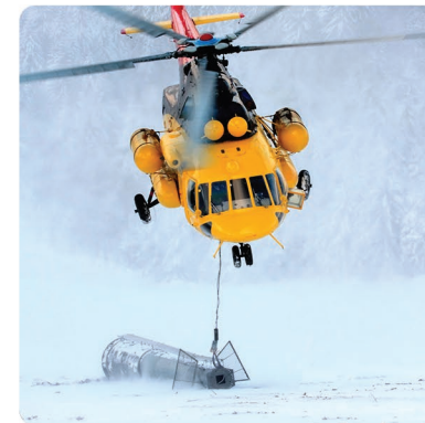
Строительно- монтажные работы
