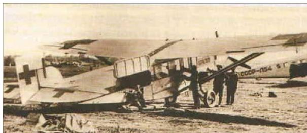
Крышка санитарного отсека самолета К-4 в открытом положении
