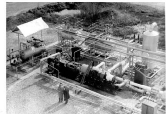
Мобильная блочная установка для получения АСКТ на месторождении
